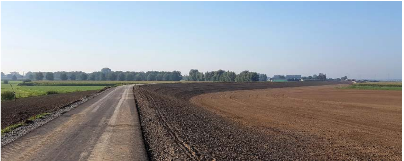
▲ Een volledig nieuwe dijk kort na aanleg. Hier is nog weinig ervaring beschikbaar over het gedrag in de praktijk.
