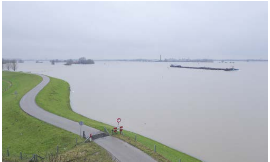
▲ Ervaringen bij eerdere hoogwaters kunnen nuttige informatie opleveren over de sterkte van een dijk. (Foto: Martin van Lokven; Rijkswaterstaat)
